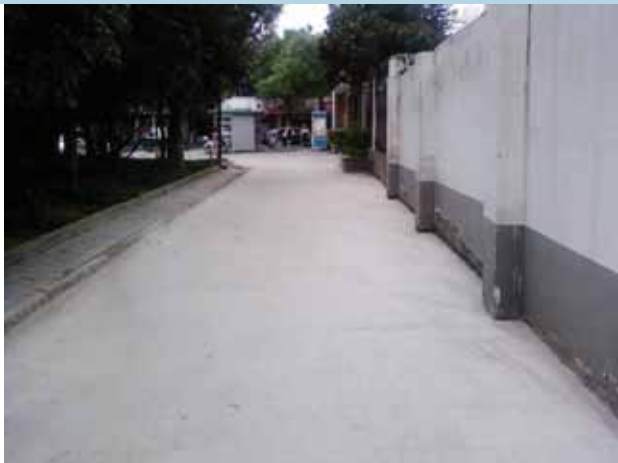
图2：维修后的道路
